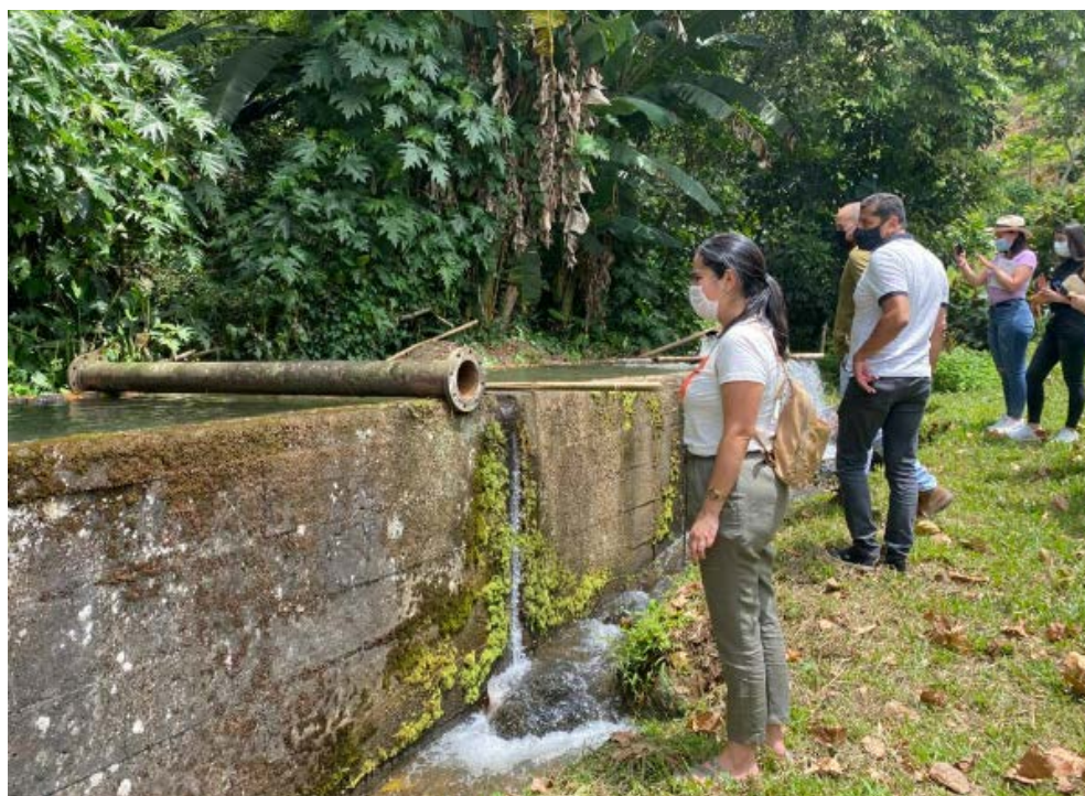
Figura 32. Acueducto veredal Viterbo
